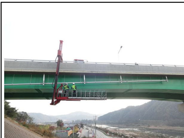
교량점검차를 이용한 외관조사
