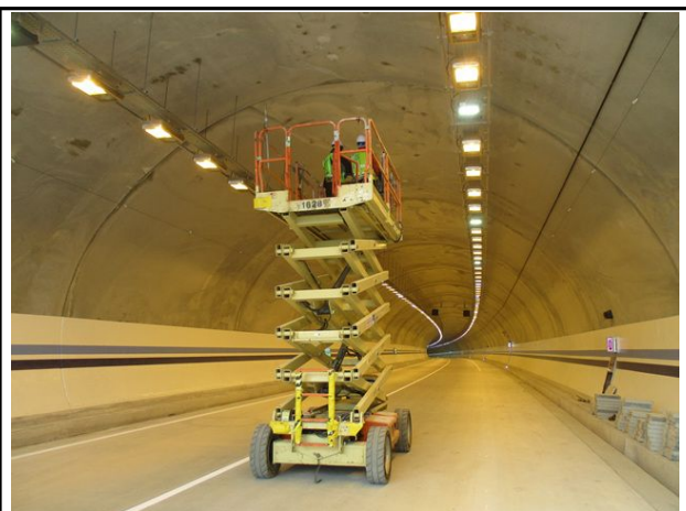
고소작업차를 이용한 외관조사
